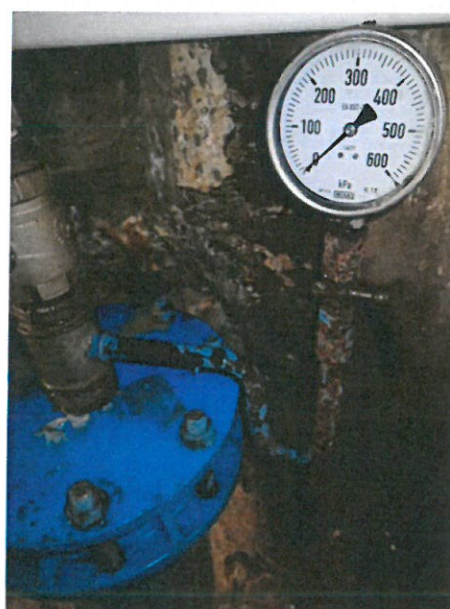
Obrázek 4 Vztlakoměrná sonda
